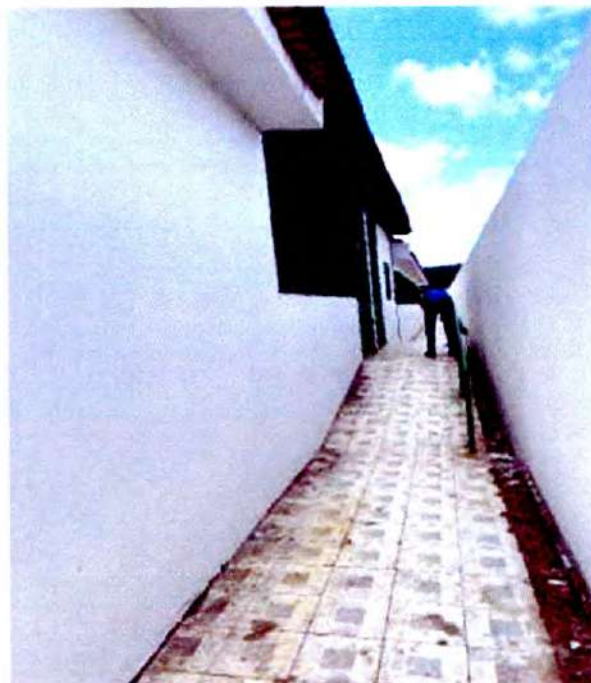
Imagem 7: Área Externa, Vista Lateral Esquerda.
