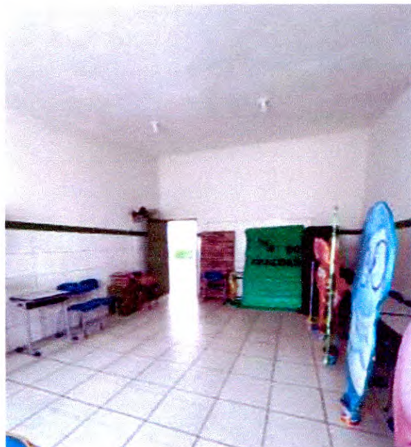
Imagem 21: Sala De Utilidades.
