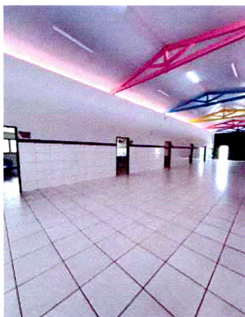
Imagem 39: Nave Central Com Acesso As Salas.
