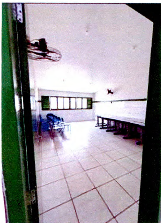
Imagem 36: Sala De Aula 05.
