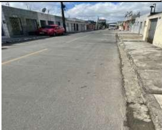
FIGURA 02: Rua asfaltada e com iluminação pública.
