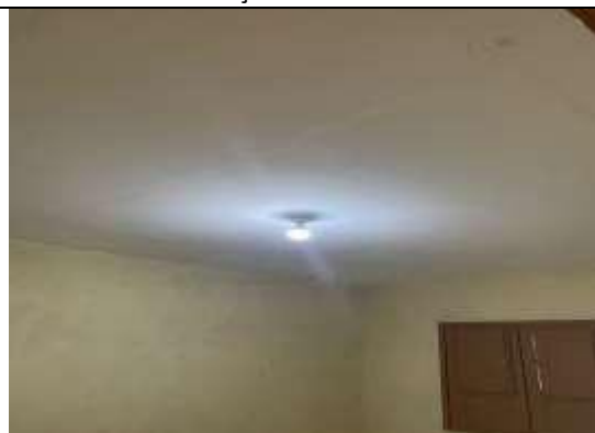
FIGURA 06: Casa com forro de gesso em todos os cômodos e energia elétrica.
