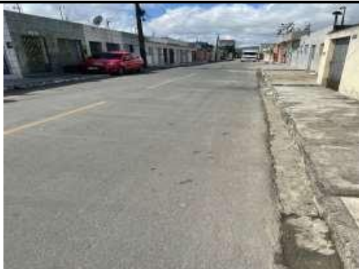
FIGURA 02: Rua asfaltada e com iluminação pública.
