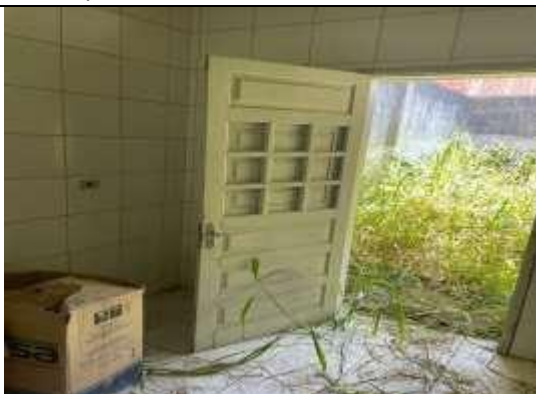
FIGURA 03: Portas em madeira e em ótimo estado de conservação.
