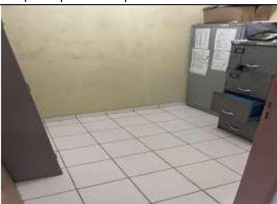
FIGURA 16: Quarto 02 com revestimento cerâmico em piso e pintura em paredes.
