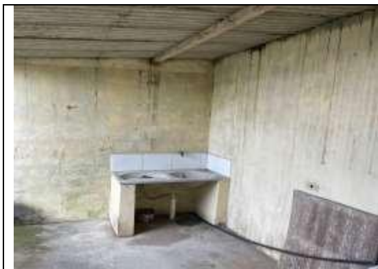
FIGURA 19: Quintal com tanque, paredes pintadas, coberta e piso
