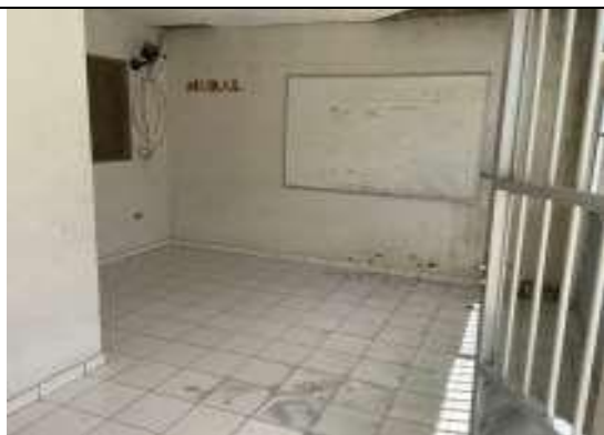
FIGURA 20: Garagem coberta e com revestimento cerâmico em piso e paredes pintadas.
