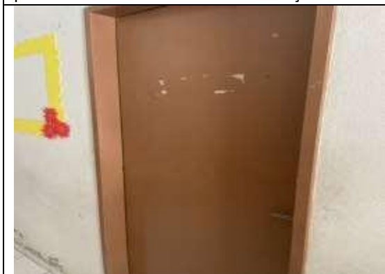
FIGURA 05: Portas em madeira e em ótimo estado de conservação.
