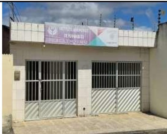
FIGURA 01: Portões de entrada de alumínio na cor prata
