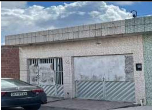
FIGURA 01: Portões de entrada de alumínio na cor prata
