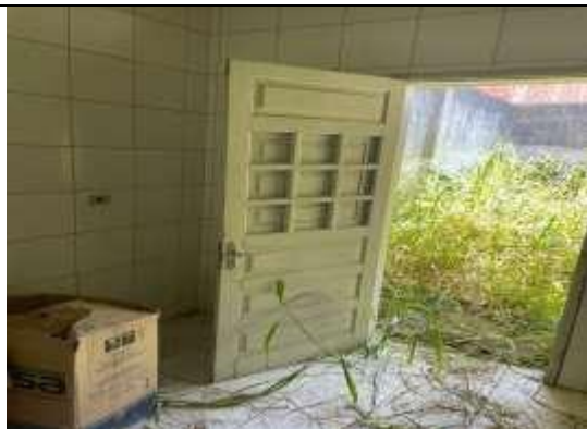
FIGURA 13: Quintal com tanque, paredes pintadas, coberta e piso
