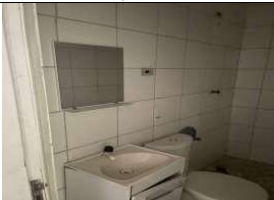
FIGURA 05: Banheiro social com revestimento cerâmico em piso e paredes, vaso, pia e chuveiro.
