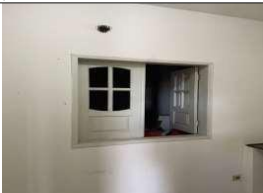
FIGURA 04: Janelas em madeira e em ótimo estado de conservação.
