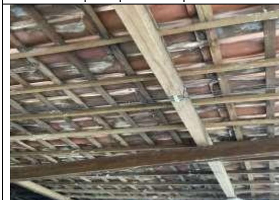
FIGURA 17: Coberta em estrutura de madeira e telhas tipo canal.
