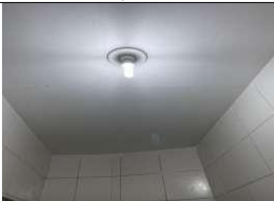
FIGURA 06: Casa com forro de gesso e energia elétrica.
