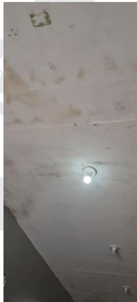
Figura 7. REFORMA E AMPLIAÇÃO DA CENTRAL DE ABASTECIMENTO FARMACÊUTICO NO MUNICÍPIO DE CAMOCIM DE SÃO FÉLIX/PE
