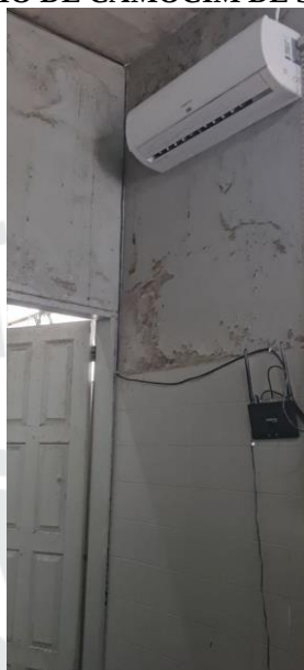
Figura 12. REFORMA E AMPLIAÇÃO DA CENTRAL DE ABASTECIMENTO FARMACÊUTICO NO MUNICÍPIO DE CAMOCIM DE SÃO FÉLIX/PE
