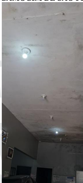
Figura 8. REFORMA E AMPLIAÇÃO DA CENTRAL DE ABASTECIMENTO FARMACÊUTICO NO MUNICÍPIO DE CAMOCIM DE SÃO FÉLIX/PE
