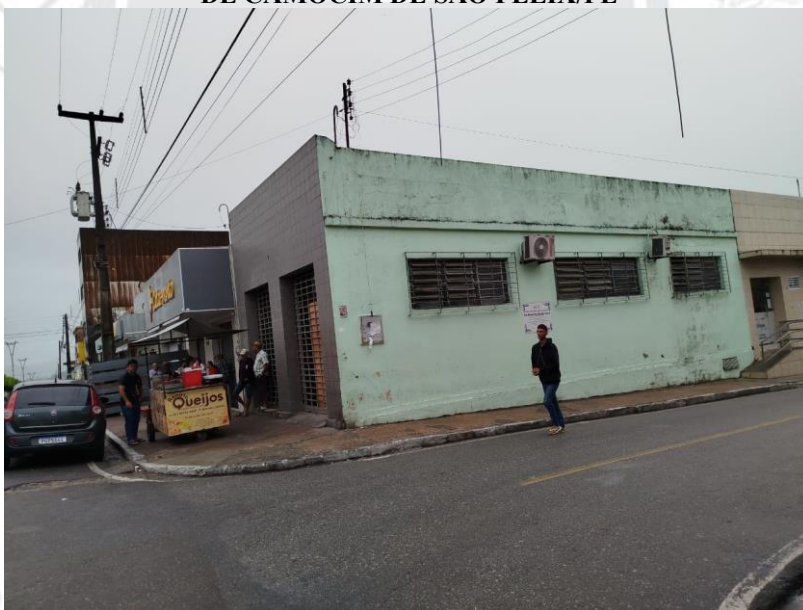
Figura 1. REFORMA E AMPLIAÇÃO DA CENTRAL DE ABASTECIMENTO FARMACÊUTICO NO MUNICÍPIO DE CAMOCIM DE SÃO FÉLIX/PE
