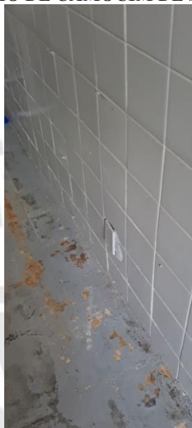
Figura 10. REFORMA E AMPLIAÇÃO DA CENTRAL DE ABASTECIMENTO FARMACÊUTICO NO MUNICÍPIO DE CAMOCIM DE SÃO FÉLIX/PE
