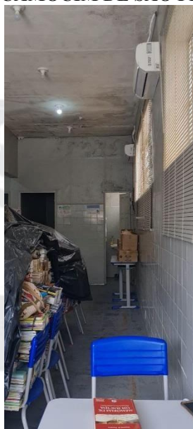
Figura 9. REFORMA E AMPLIAÇÃO DA CENTRAL DE ABASTECIMENTO FARMACÊUTICO NO MUNICÍPIO DE CAMOCIM DE SÃO FÉLIX/PE
