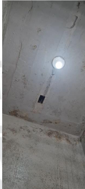
Figura 14. REFORMA E AMPLIAÇÃO DA CENTRAL DE ABASTECIMENTO FARMACÊUTICO NO MUNICÍPIO DE CAMOCIM DE SÃO FÉLIX/PE
