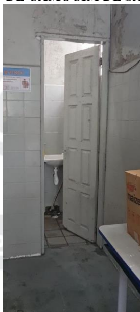
Figura 11. REFORMA E AMPLIAÇÃO DA CENTRAL DE ABASTECIMENTO FARMACÊUTICO NO MUNICÍPIO DE CAMOCIM DE SÃO FÉLIX/PE
