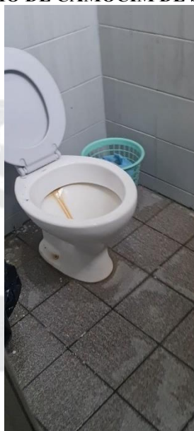
Figura 13. REFORMA E AMPLIAÇÃO DA CENTRAL DE ABASTECIMENTO FARMACÊUTICO NO MUNICÍPIO DE CAMOCIM DE SÃO FÉLIX/PE
