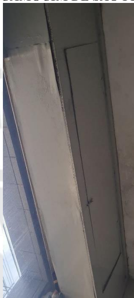
Figura 6. REFORMA E AMPLIAÇÃO DA CENTRAL DE ABASTECIMENTO FARMACÊUTICO NO MUNICÍPIO DE CAMOCIM DE SÃO FÉLIX/PE
