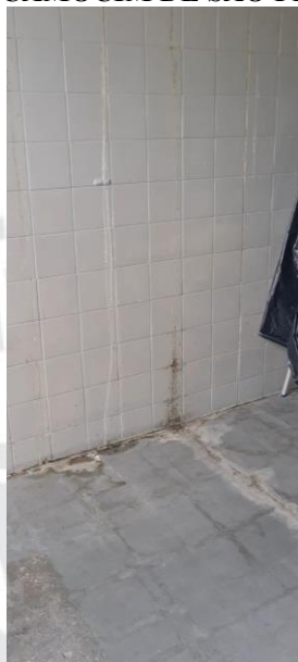
Figura 4. REFORMA E AMPLIAÇÃO DA CENTRAL DE ABASTECIMENTO FARMACÊUTICO NO MUNICÍPIO DE CAMOCIM DE SÃO FÉLIX/PE
