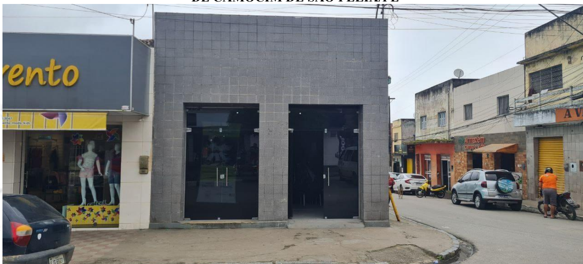
Figura 2. REFORMA E AMPLIAÇÃO DA CENTRAL DE ABASTECIMENTO FARMACÊUTICO NO MUNICÍPIO DE CAMOCIM DE SÃO FÉLIX/PE
